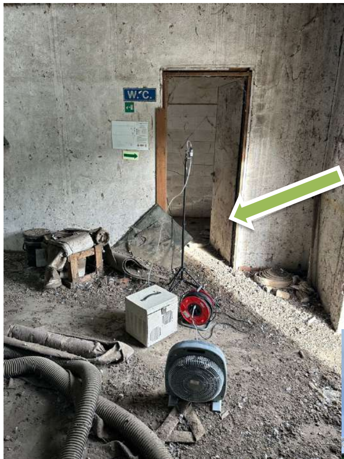
Punto P 3 : POSTAZIONE FISSA AMBIENTALE INTERNO REPARTO RAFFINAZIONE (DISMESSO) (Rapporto di prova: 23LA10826)
