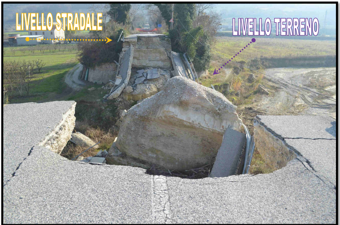
Figura 3: Particolare dei pilastri crollati; le frecce indicano il livello del terreno attuale e si evince come i pilastri e l'attuale carreggiata stradale sorgano sopra un rilevato artificiale
