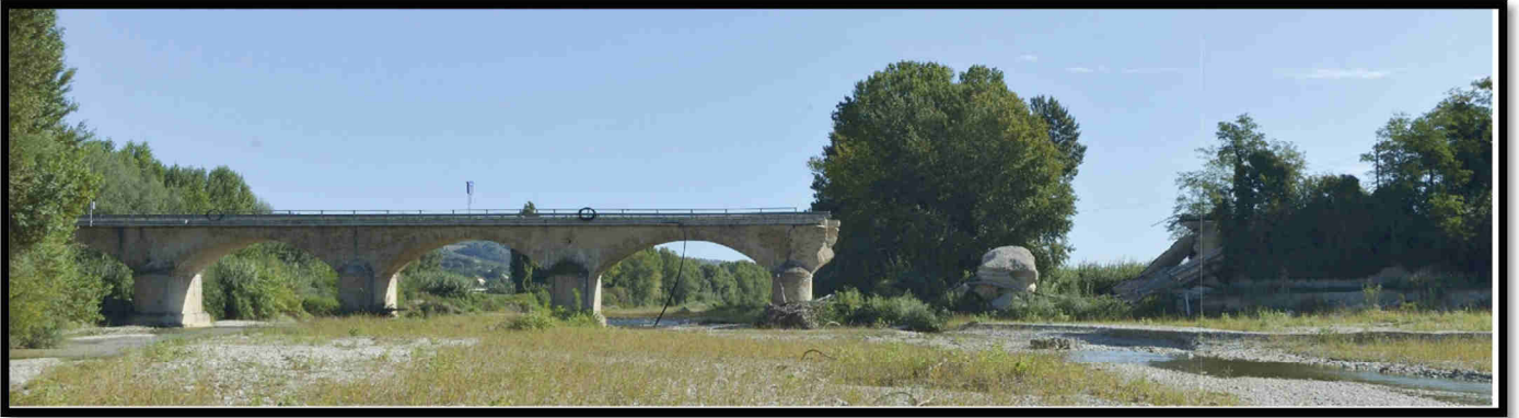
Figura 2 Panoramica da Ovest del Ponte crollato
