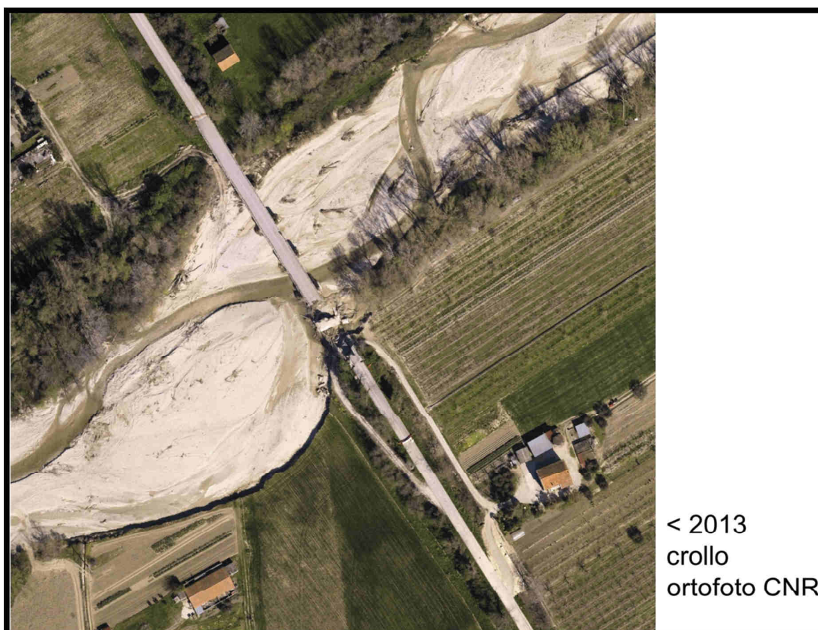
Figura 6: Ortofoto con il crollo del ponte
