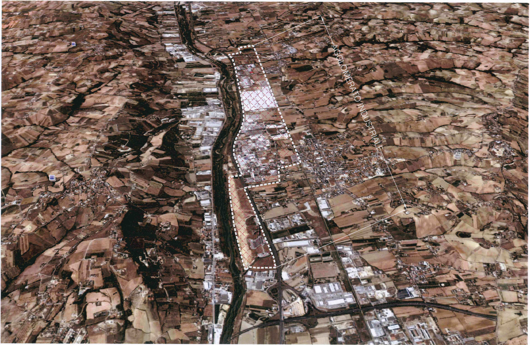
VEDUTA DA EST DELL'AGGLOMERATO INDUSTRIALE
