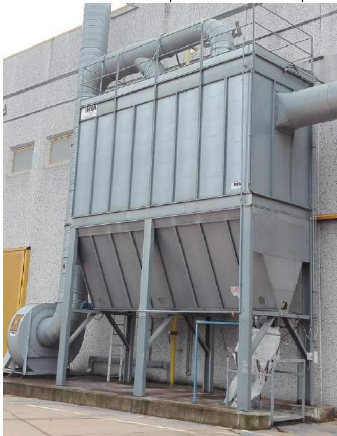
Figura 71: Sistema di abbattimento delle polveri annesso all'impianto di aspirazione
